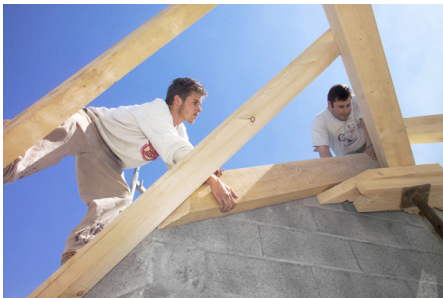
Abb. 96 | Ein Zimmermann bei der Arbeit
