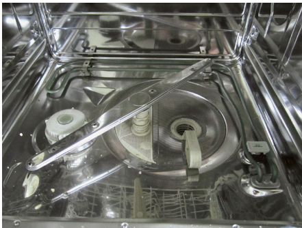
Abb. 247 | Hier wird gerade die Sprühdüse montiert.
