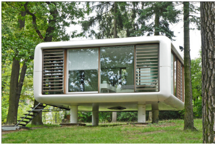
Abb. 284 | 2003 entwickelte der deutsche Designer Werner Aisslinger den Loft Cube – einen mobilen Wohnwürfel. Der Loft Cube bietet 39 m 2 und zieht mit seinen Bewohnenden um. Er kann bei Bedarf mit einem Kran oder einem Helikopter an den neuen Standort geführt werden.
