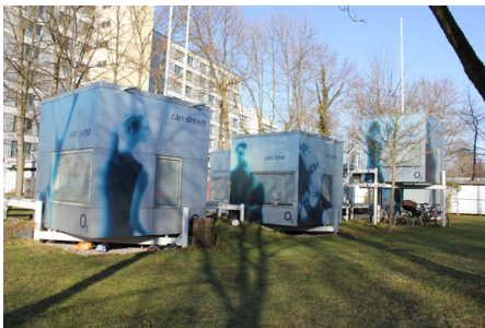
Abb. 285 | Wohnwürfel in der Studentenstadt Freimann in München. Das Micro Compact Home (m-ch) wurde in München unter der Leitung des Architekturprofessors Richard Horden im Jahr 2002 entwickelt. Jeder Wohnwürfel hat eine Kantenlänge von 2,66 m.
