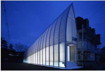
Abb. 286 | Lucky Drops vom Atelier Tekuto in Tokio. Aussergewöhnliche Grundstücke erfordern aussergewöhnliche Häuser. Dieses hat eine trapezförmige Grundfläche und ist an seiner schmalsten Stelle gerade einmal 76 cm breit.
