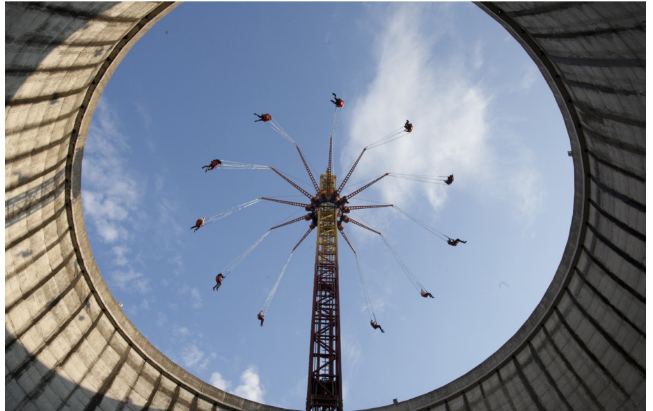
Abb. 02 | Ein Kühlturm eines Atomkraftwerks, das nie ans Netz ging, und mittendrin ein Kettenkarussell: das heutige Spielparadies «Wunderland Kalkar» (Deutschland). Der Vertical Swing vereint zwei technische Errungenschaften.
