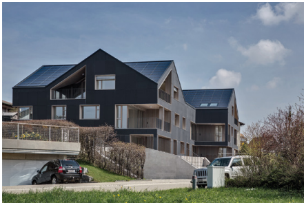
Abb. 307 | Das erste energieautarke Mehrfamilienhaus der Welt steht in Brütten ZH.
