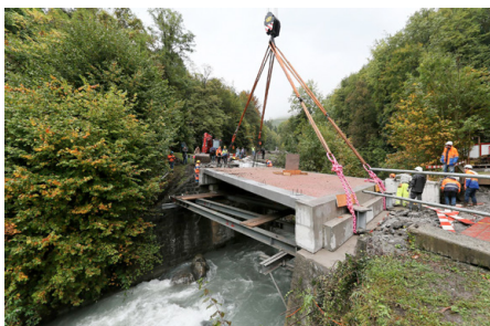
Abb. 209 | Die komplette Balsaholzbrücke wird in Bex (VD) aufgestellt.
