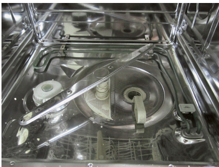
Abb. 271 | Hier wird gerade die Sprühdüse montiert.
