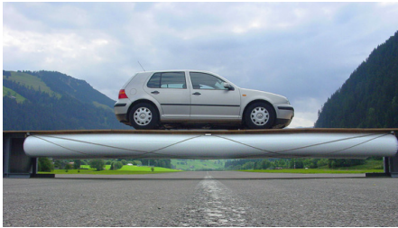
Abb. 144 | Die Tensairity-Brücke besteht zu einem Grossteil aus Luft und hält dennoch einem Gewicht von zwei Kleinwagen stand.
