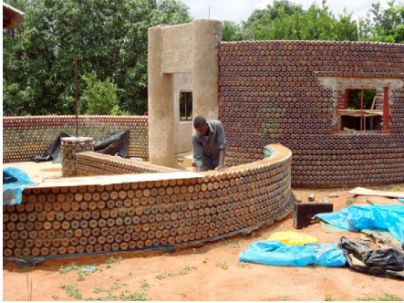
Abb. 42 | Ein Haus entsteht aus mit Sand gefüllten PET-Flaschen.
