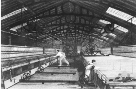
Abb. 111 | Spinnfabrik Anfang des 19. Jahrhunderts
